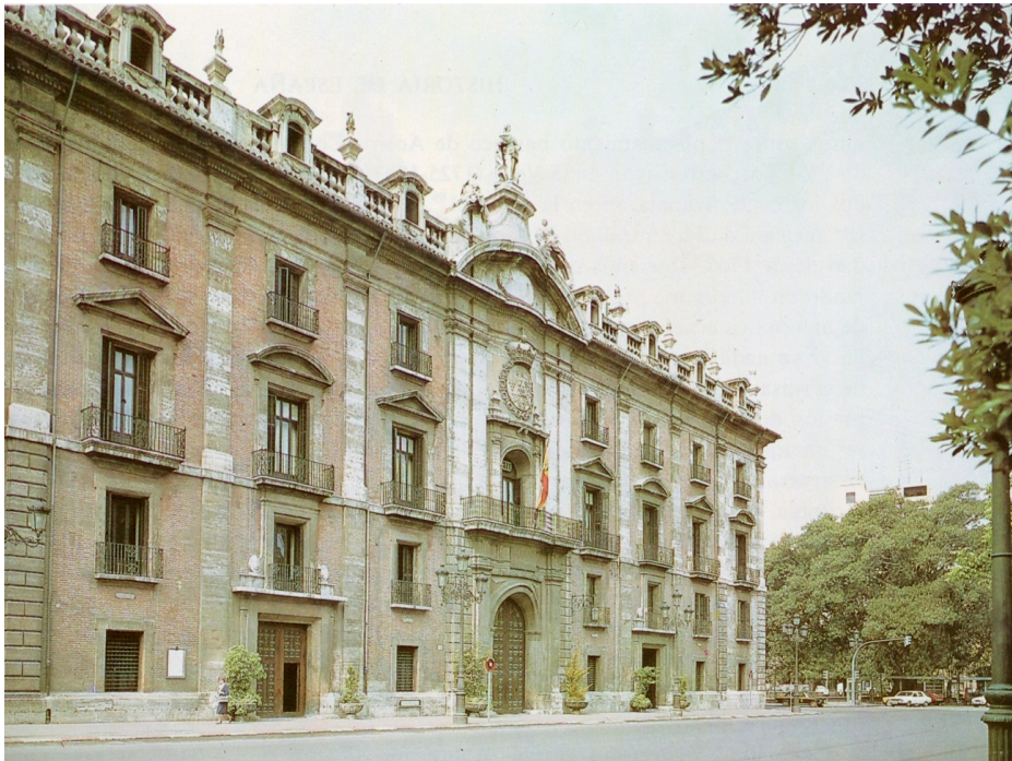
Figura 33. Edificio de la Aduana, hoy Palacio de Justicia, en Valencia.
