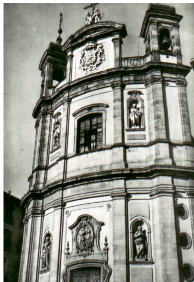
Figura 5. Fachada de la Iglesia de los Santos Justo y Pastor de Madrid, del arquitecto italiano Bonavía
