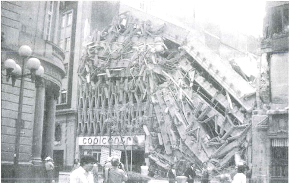
Por ejemplo, el seísmo ha afectado seriamente a un edificio, y no a otros.
