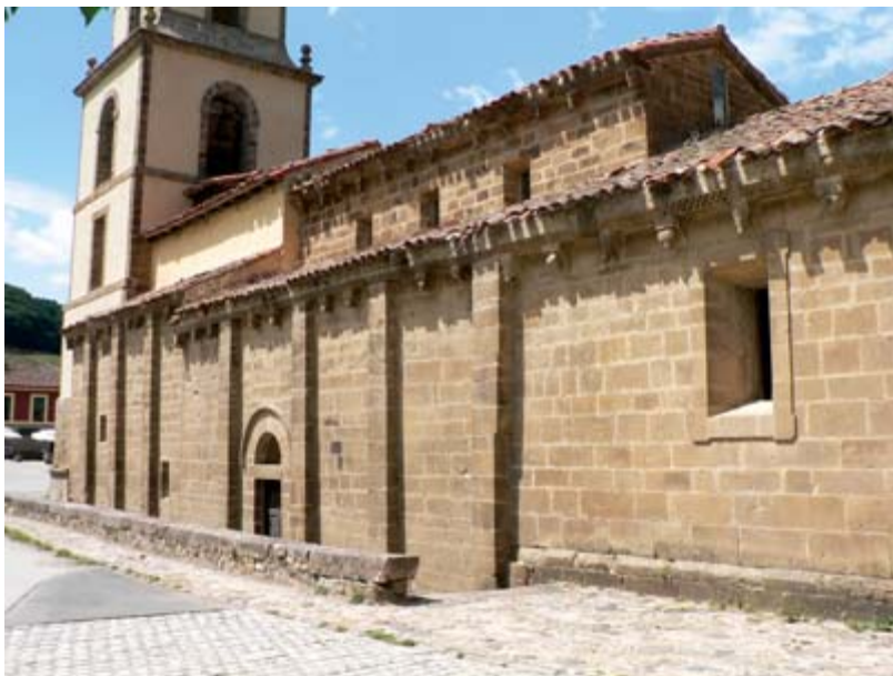
Figura 15. Colegiata de San Pedro de Teverga (Asturias) (mediados del siglo XI), con su «cuerpo occidental» de dos pisos, algo más elevado que el de naves, al que precede.
